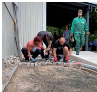
Teilnehmer*innen des GaLaBau-Praxistages verlegen unter Anleitung der Azubis Natursteinpflaster. Foto: FGL
