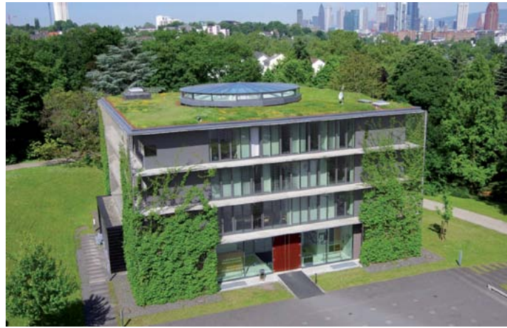
Die bodengebundene Fassadenbegrünung an der Philosophisch-Theologischen Hochschule in Frankfurt/Main sorgt für Kühlung im Sommer sowie den Eintrag von Sonnenwärme im Winter. Die Dachbegrünung hält Regenwasser zurück.
