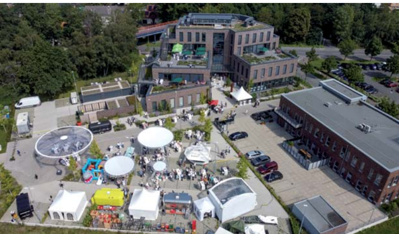
Das neue Haus der Grünen Verbände in Oberhausen.
