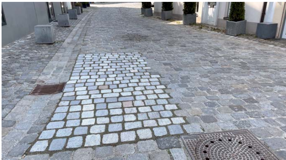
In der Ulmer Altstadt hat KSV Biberach eine Musterfläche mit oberflächenbeschnittenen Pflastersteinen in Kombination mit einer Flexystone®-Verfugung angelegt. So entsteht ressourcenschonend eine barrierefreie Fläche mit geringen Unterhaltskosten.
