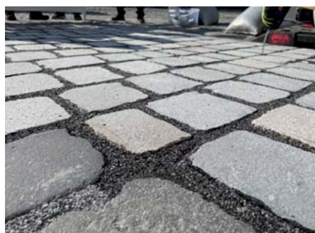
Nachher: Die vorhandenen Pflastersteine wurden bearbeitet und der Belag mit Flexystone® verfügt.
