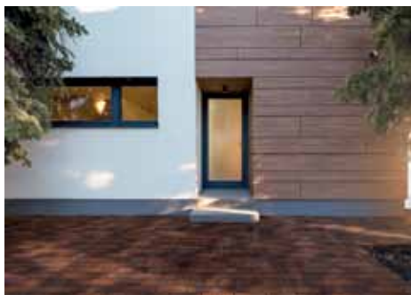
Pflasterklinker sind dank ihrer gleit- und rutschfesten Eigenschaften sowie aufgrund ihrer Resistenz gegen Hitze, Kälte und UV-Licht ein idealer Bodenbelag.
