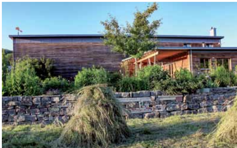
Trockenmauer aus Naturstein und Recycling- Material (Betonplatten, Ziegel, Grabsteine etc.).
