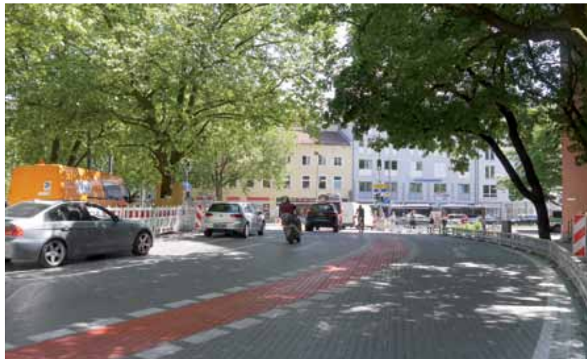
Baustraße am Sendlinger Tor, München
