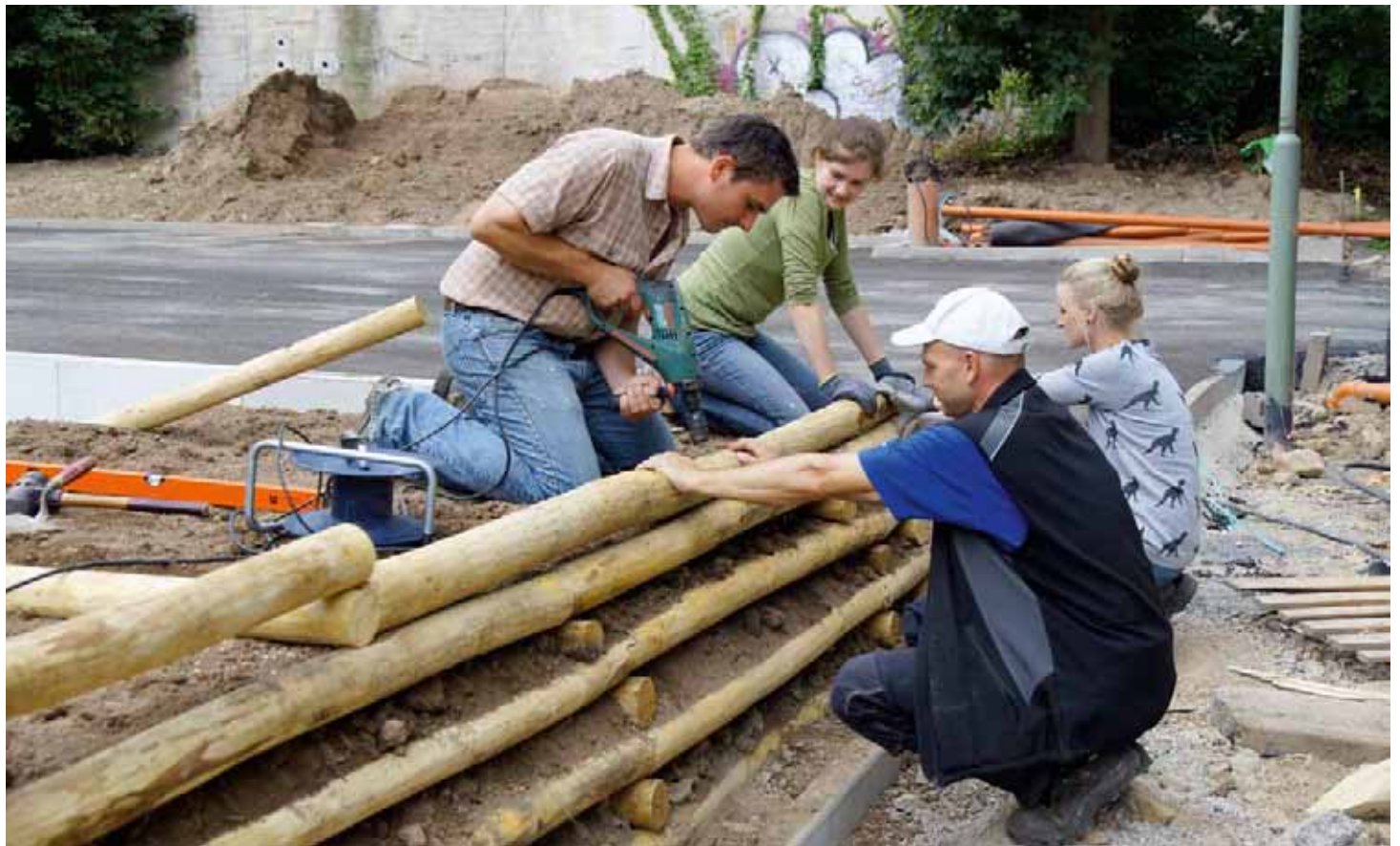
Für den Therapiegarten bauten die Studierenden der Universität Kassel unter anderem eine „Krainerwand“. Die Bezeichnung wird auf die slowenische Landschaft Krain zurückgeführt.
