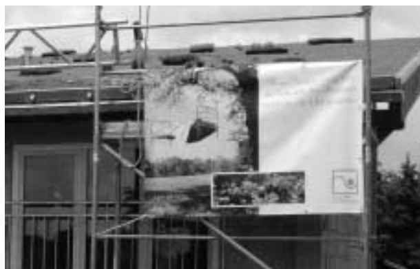
Werbung an der Baustelle. Zwei Bauzaunplanen aus der GaLaBau-Imagekampagne machen die Zuschauer auf die Mitgliedsbetriebe aufmerksam.
