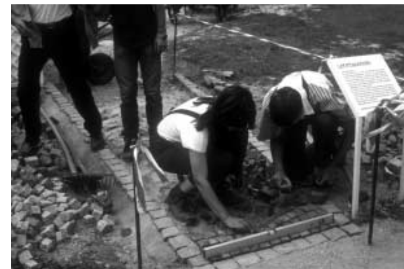
Pflastern in aller Öffentlichkeit: die Lehrbaustelle auf einer Gartenschau
