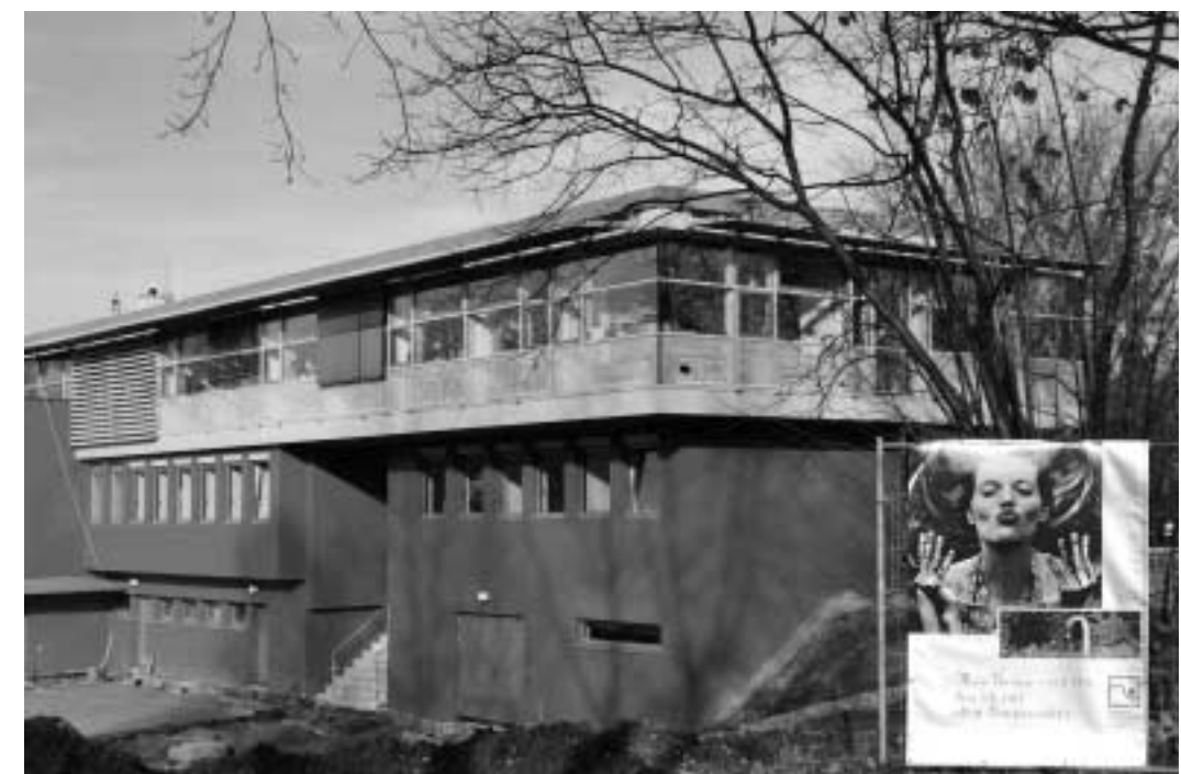
Die neue Geschäftsstelle der GaLaBau-Verbände in NRW in Oberhausen
