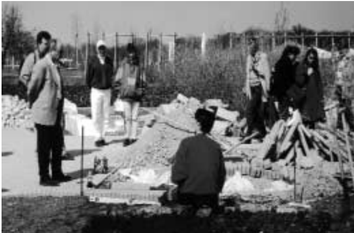
Die Lehrbaustelle macht ihrem Namen alle Ehre und zeigt, wie viel Arbeit und landschaftsgärtnerisches Können zum Bau eines Themengartens notwendig sind
