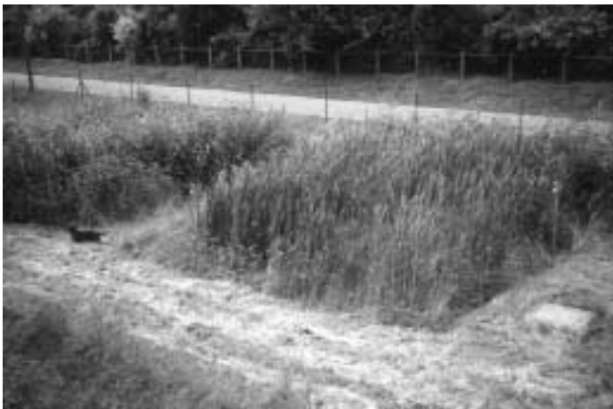
Pflanzenkläranlagen sind sowohl naturnahe als auch technische Anlagen. Zu- und Ablauf müssen kontrollierbar sein.
