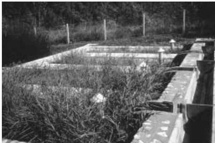
Die Klärschlammvererdung in Schilfbeeten gewinnt immer mehr an Bedeutung. Sie ist ein kostengünstiges Verfahren zur Entwässerung
